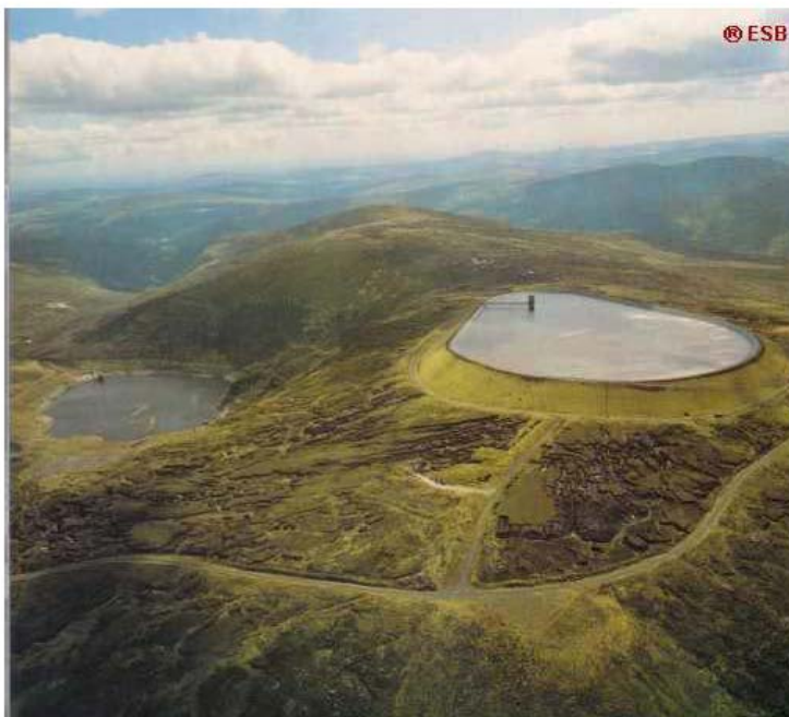
Σχήμα 1 Σύστημα αντλησιοταμιευτήρων στην περιοχή Turlough Hill, Wicklow της ανατολικής Ιρλανδίας Όγκος άνω δεξαμενής 2.300.000m 3 , 4 αεριοστροβιλικές αντλίες 73MW
